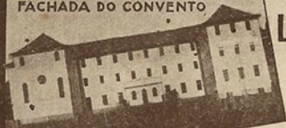
FACHADA DO CONVENTO
