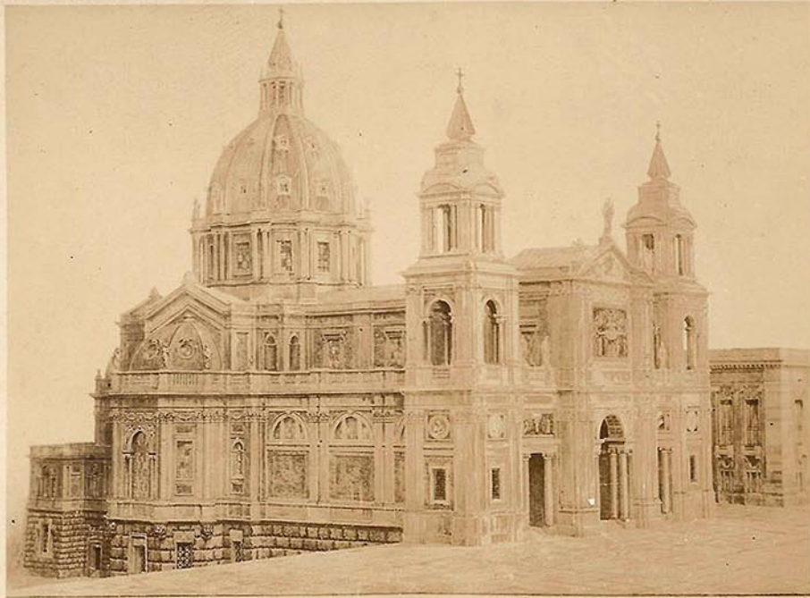
A catedral de Porto Alegre em construção, toda de granito rio-grandense - Dimensões: 80 m de altura da fachada, 30 m das torres, 50 m da cúpula, 65 m Projeto do célebre arquiteto romano G. B. Giovenale - Executado pela escola de Engenharia de Porto Alegre - Preço 18.000 pròs catedral.
